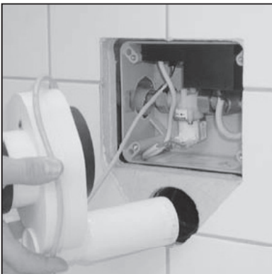
Keramik abnehmen. Sensorsiphon herausziehen und Stecker beim Elektronikmodul lösen.
