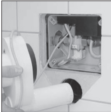
Sensorsiphon herausziehen und von der Elektronik abstecken
