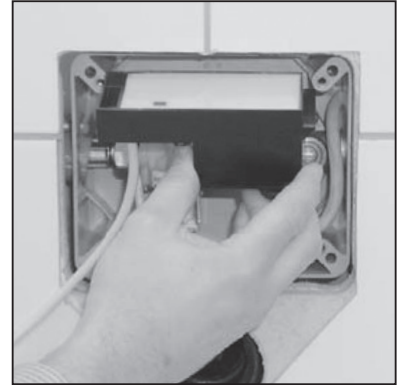
Elektronikmodul aus dem UPKasten entnehmen
