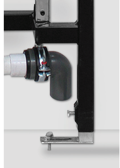
9. Füße mit Schrauben fixieren
